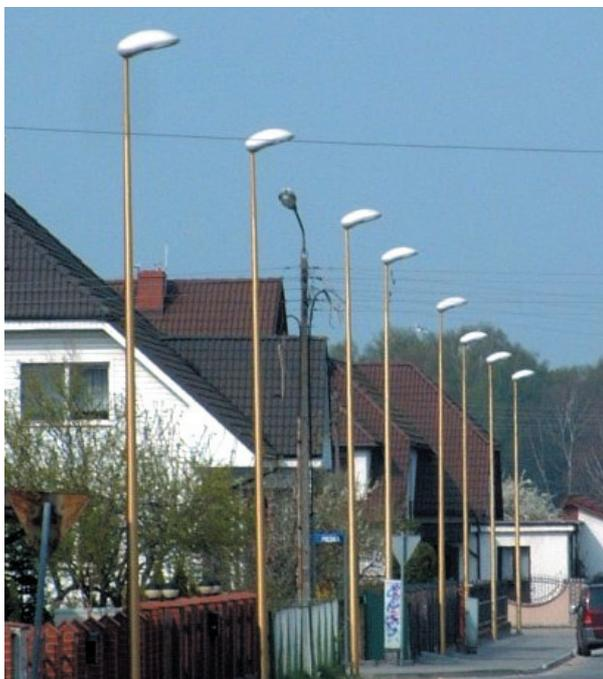
Les mâts de la série ALTAIR ont la particularité d'être MONOBLOC jusqu'à 10 mètres, c'est une technologie mis en place dans notre usine avec des bancs de conification des tubes adaptés à cette longueur maximale. Les versions « K » et « M » sont adaptées en standard au montage de lanterne en **Top 76** et en **Top 60**.
